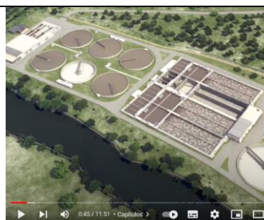
Figura 2. Visita virtual Estación Depuradora de Aguas Residuales (EDAR) de Acciona en Lugo ( https://www.youtube.com/watch?v=d8ZedbiZBXM ).
